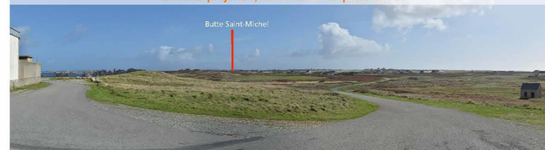
Panorama 15 : Depuis l'entrée du phare du Créac'h, les vues sont assez lointaines et permettent une identification par beau temps du relief du fort Saint-Michel sans en distinguer les détails.
